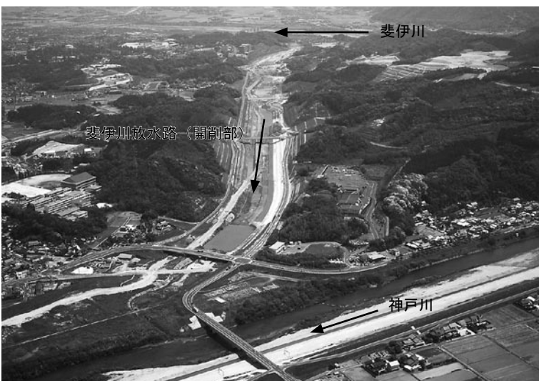
放水路工事の現況
