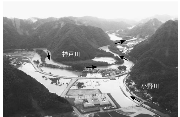
② 殿森地区から宇和佐・木村地区の被災状況
