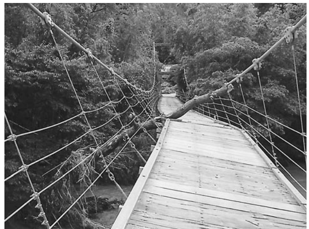
谷合橋：被災後
