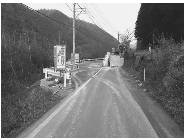
写真-3 JR23仮設道
