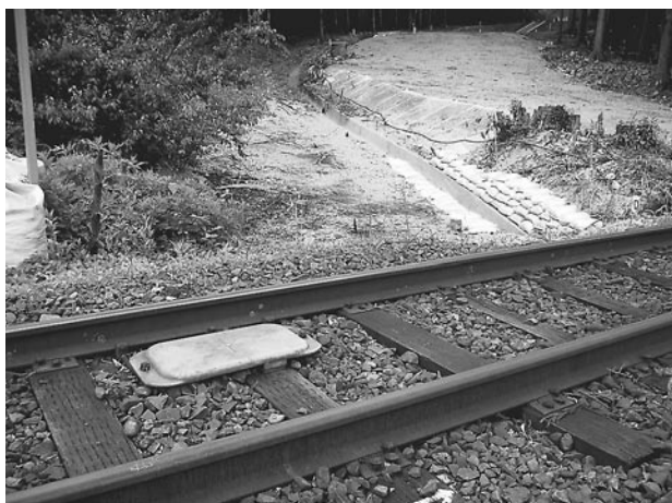
写真-10 完成写真 写真8と同じ方向から撮影したもの。土砂は完全に排除している。
