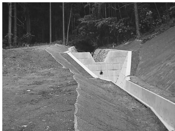
写真-11 完成写真 残存型枠を使用した床固め工とプレキャスト水路。
