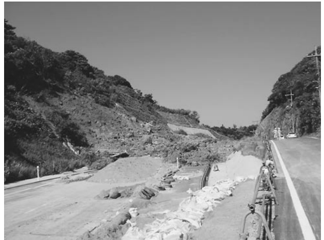
写真6－仮設道路設置状況
