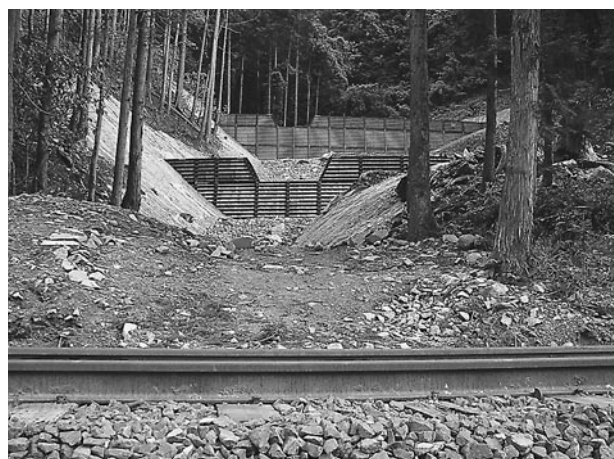
写真-4 JR23復旧状況
