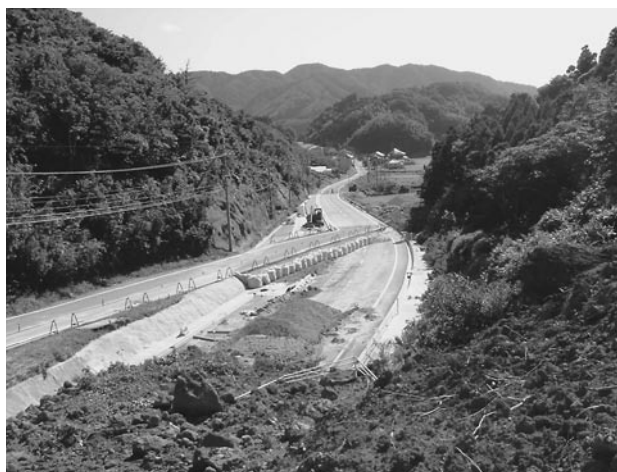
写真7－仮設道路設置状況
