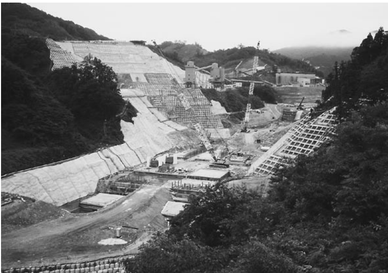
尾原ダム工事の現況
