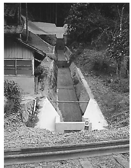
写真-7 JR35復旧状況
