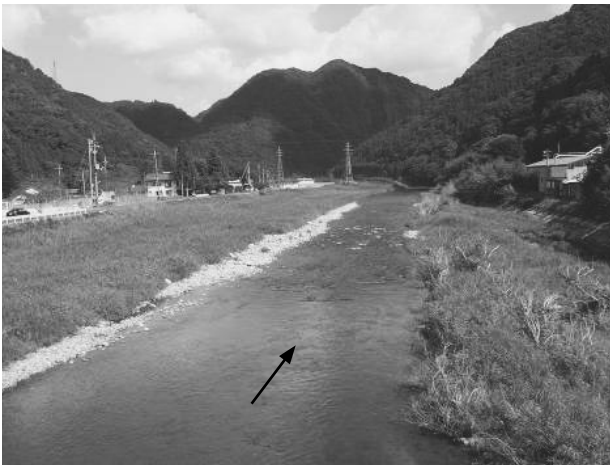
施工前 平成19年 5 月
