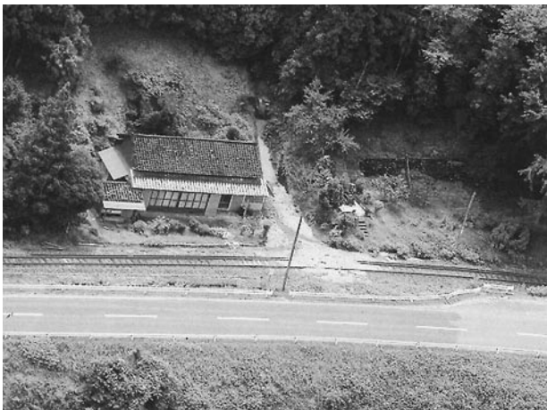
写真-5 JR35被災状況
