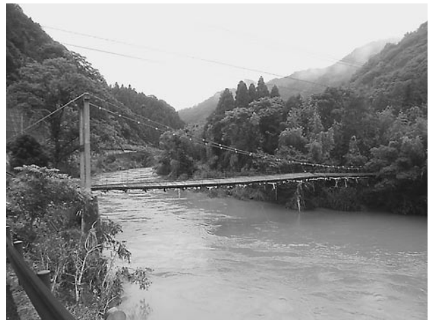
谷合橋：被災後
