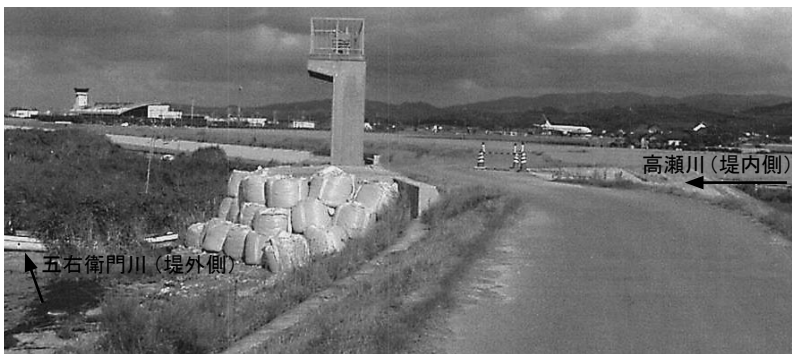
写真-1 高瀬川逆流防止樋門 全景
