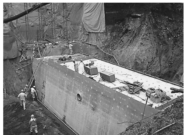
内部にコンクリートを打設した状態
