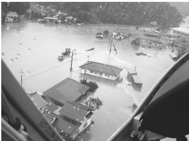
① 桜地区被災状況（右端：朝山小学校）
