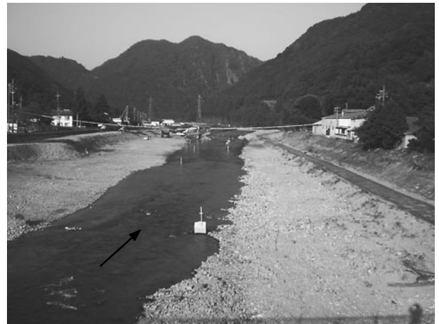
施工中 平成19年10月
