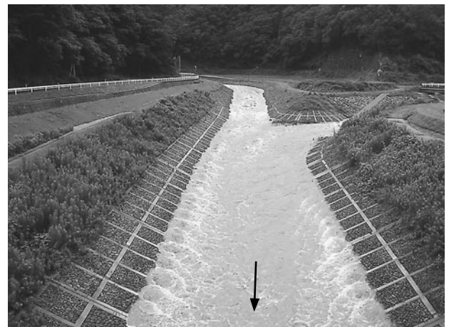
(小谷川・長戸路川合流部の状況)
