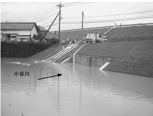
(小谷川排水樋門呑口部の状況)
