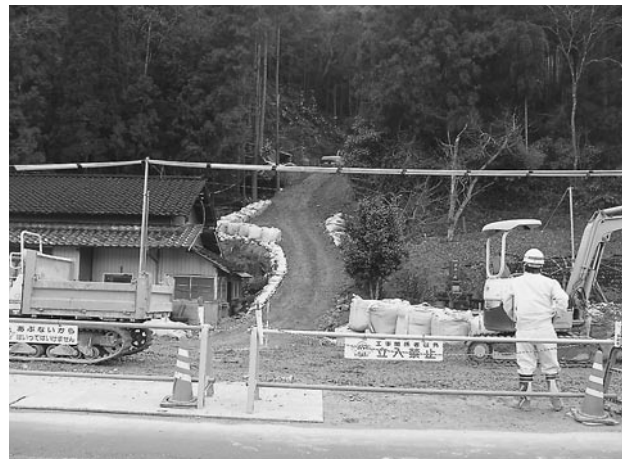
写真-6 JR35仮設道
