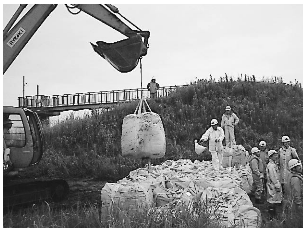
大型土のう積による応急対策工事
