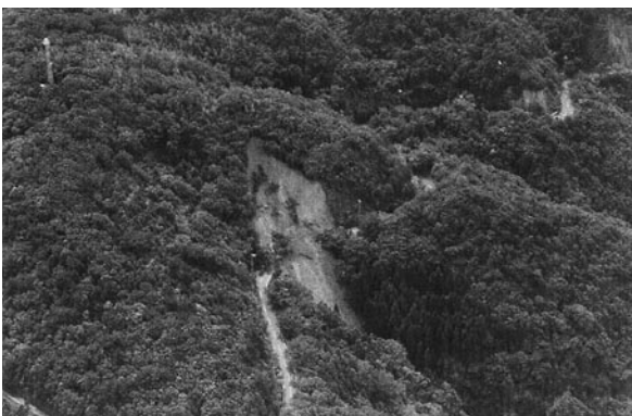
写真1：枕木山線で最大の崩土箇所 (航空写真・図面提供：国土交通省大阪航空局レーダー観測所)
